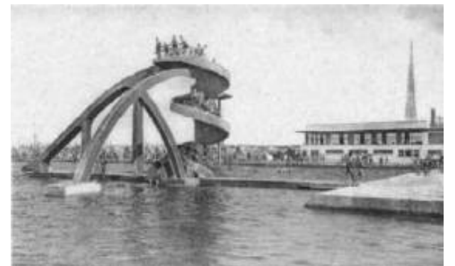
Photo 4 et 5. La Piscine Municipale Georges Orthlieb
