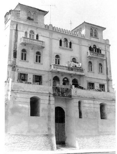
Photo 5 : Maison en médina sur les murailles
