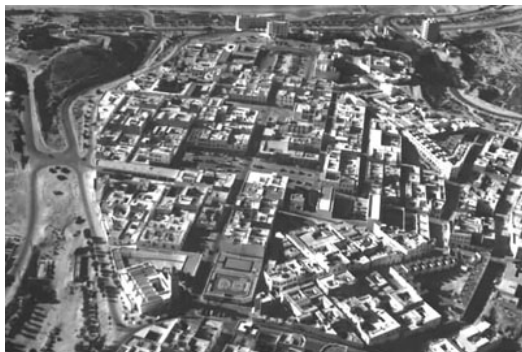
Photo 1 : Talbordj avant le séisme
